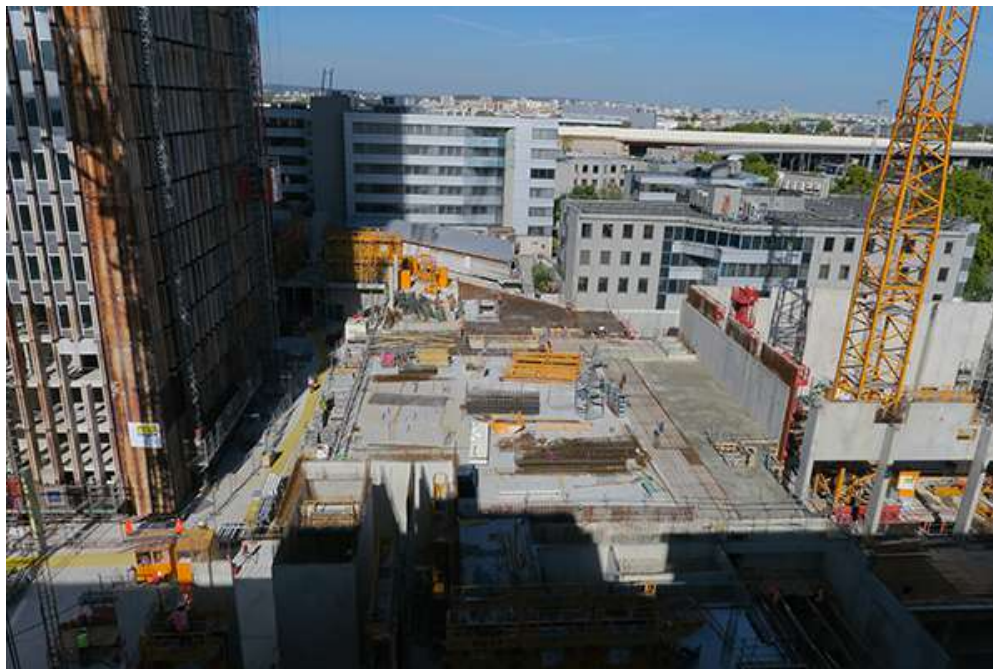
Sur le chantier du Paris Pleyel business resort, début octobre 2022 : au pied de la tour Pleyel complètement restructurée, trois nouveaux bâtiments sont en train de sortir de terre. © Jgp
