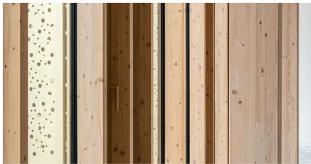
La structure bois de l'immeuble de bureaux 22 rue Bayard, à Paris. Simon Guesdon
