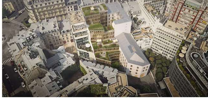
Vue aérienne de l'immeuble de bureaux 22 rue Bayard à Paris, le premier en ossature bois du quartier central des affaires. Axel Schoonert architectes
