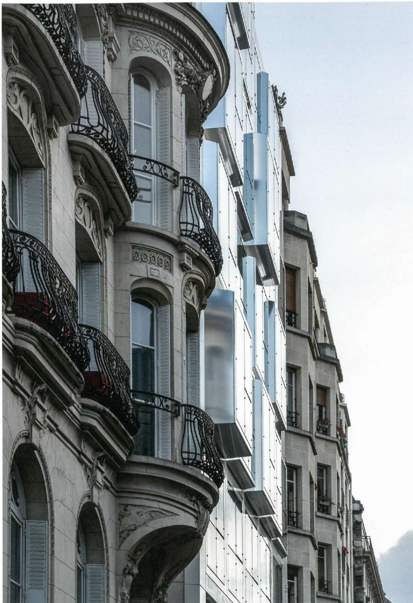
Entre un bel hôtel particulier haussmannien néoclassique et un élégant immeuble Art déco, une rénovation exemplaire.
