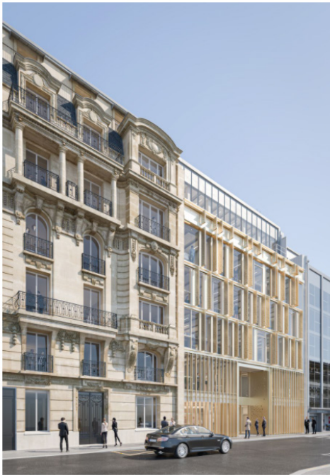
La façade de cet immeuble de plus de 8000 m 2 affiche bien sa dimension "bois"... Crédit: cabinet Axel Schoenert Architectes
