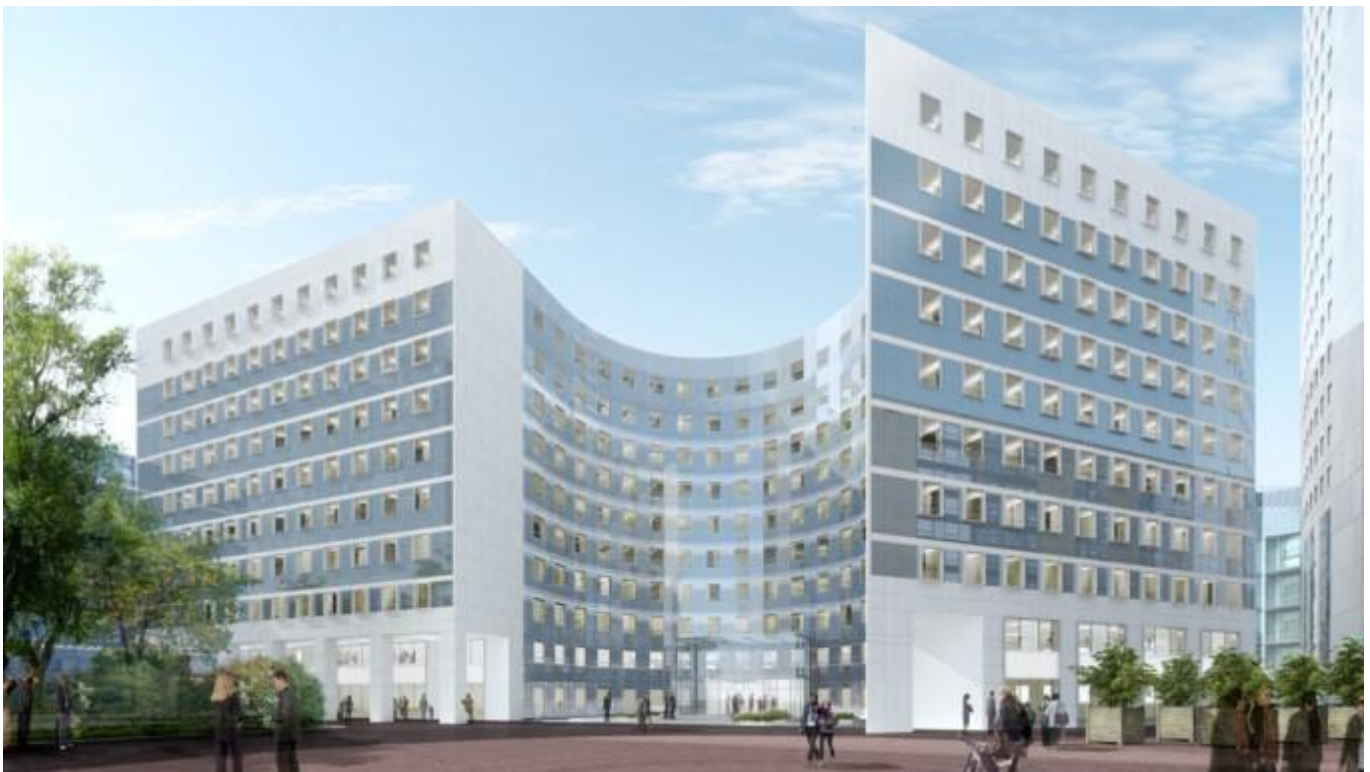
L'immeuble Le Belvédère à La Défense © D.R.
